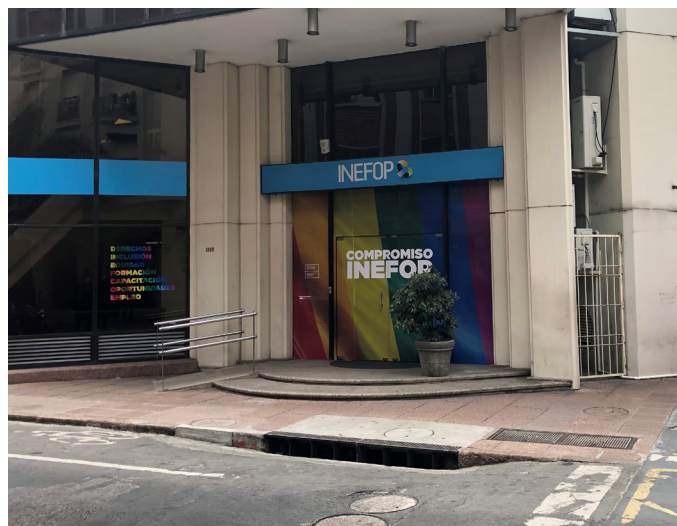
Intervención en fachada - Diversidad
