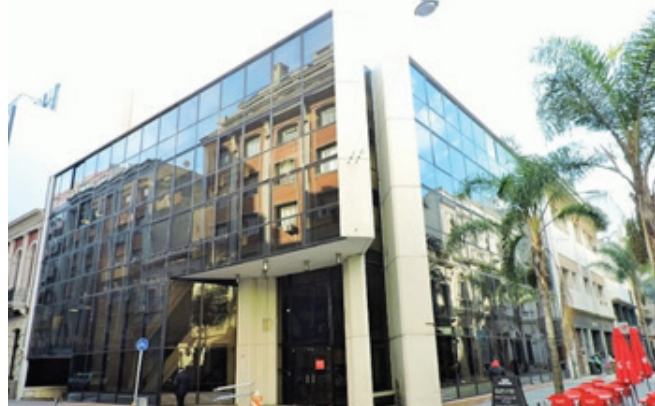
Edificio que será la futura sede de INEFOP
